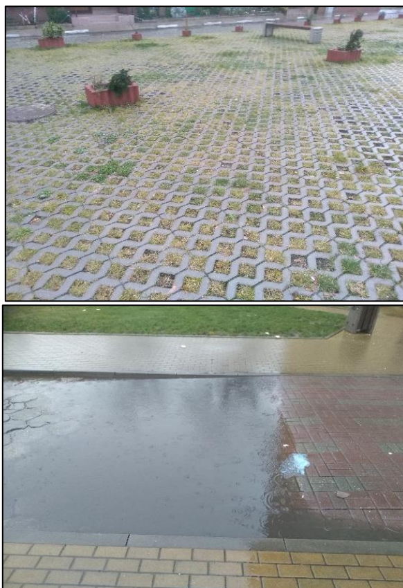
Ryc. 8.3.1. Wizualizacja skuteczności działania płyt ażurowych w obliczu opadu (Jelitkowo/Gdańsk 04.01.2020)
